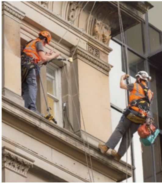
Travaux à la corde
